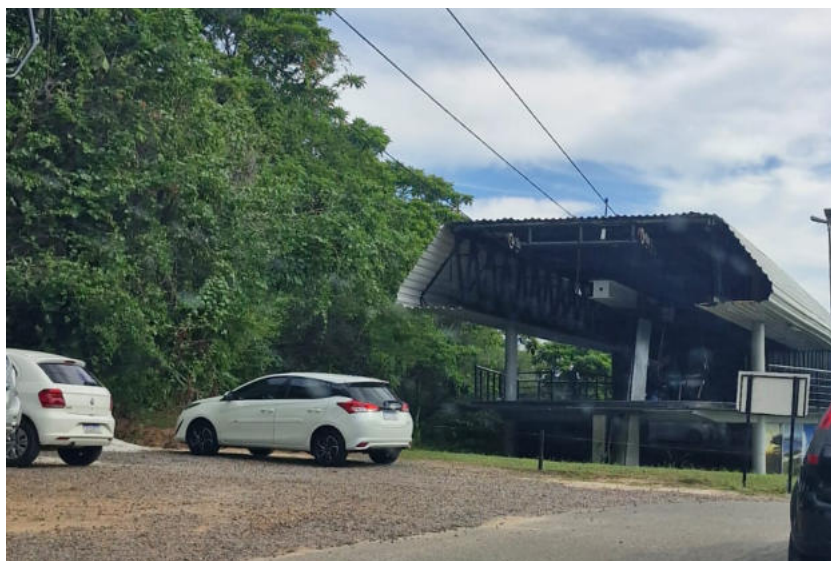
Figura 27: Fachada do teleférico
