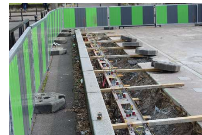
Figura 21: Instalação de uma estação Vélib' Métropole.
