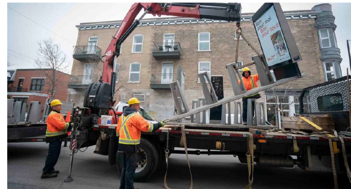
Figura 12: Instalação de uma estação modular BIXI.
