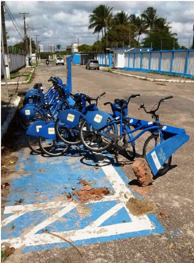
Figura 84: Estação Mediterrâneo após vandalismo ocorrido em 2016. Fonte: Prefeitura de Aracaju, 2016a.
