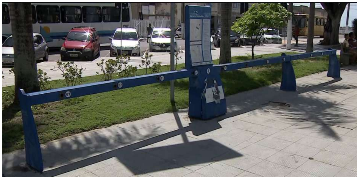
Figura 87: Estação Caju Bike após o encerramento do serviço e da retirada de bicicletas.
