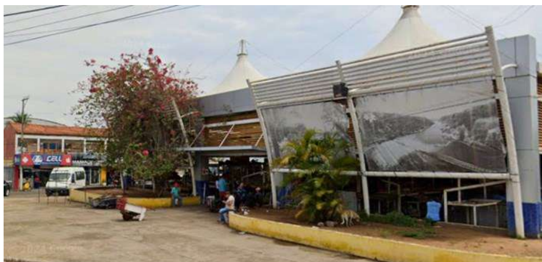
Figura 46: Entrada oeste do Mercado Municipal
