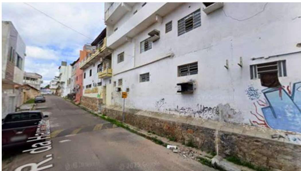
Figura 51: Restos do antigo muro da vergonha, atualmente usado como fundação para os sobrados da rua.
