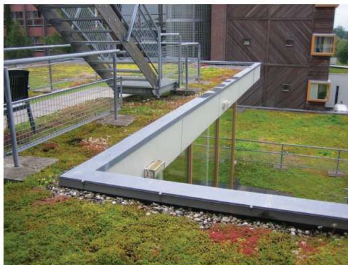
Figura 5: Teto verde no edifício sustentável Lumen da Alterra em Wagenunge, Holanda.
