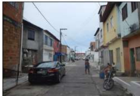
Figura 32. Os moradores tiveram de se adaptar e elevar o piso das casas. Na via se vê a canalização do curso d'água.
