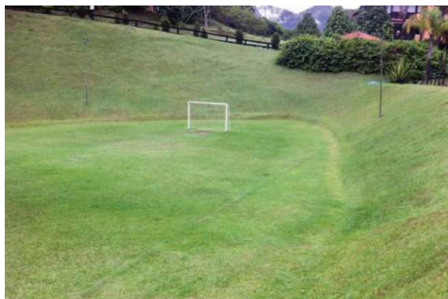
Figura 3: Campo de Futebol que acomoda as águas em tempos de chuva forte, reduzindo o escoamento superficial e melhorando a capacidade de drenagem do sistema.
