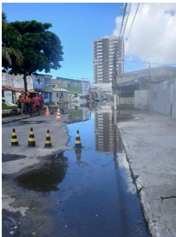
Figura 30: Inundação ocorrida no ano de 2025 no mês de julho no Largo da Aparecida.
