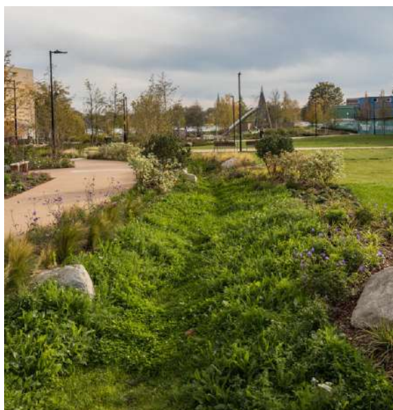
Figura 8: Vala de Infiltração.
