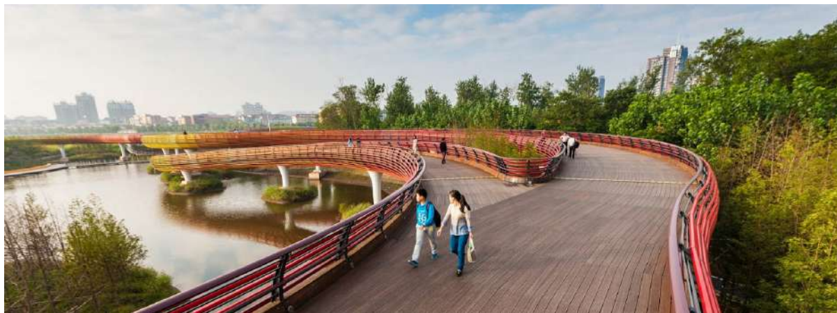
Figura 41: Ponte para pedestres.
