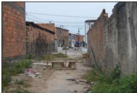
Figura 31. Local de desemboque do curso d'água canalizado. Moradias próximas sofrem com inundações.
