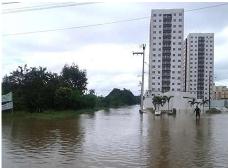
Figura 21: Alagamento na Avenida Graciliano Ramos, Jabotiana.
