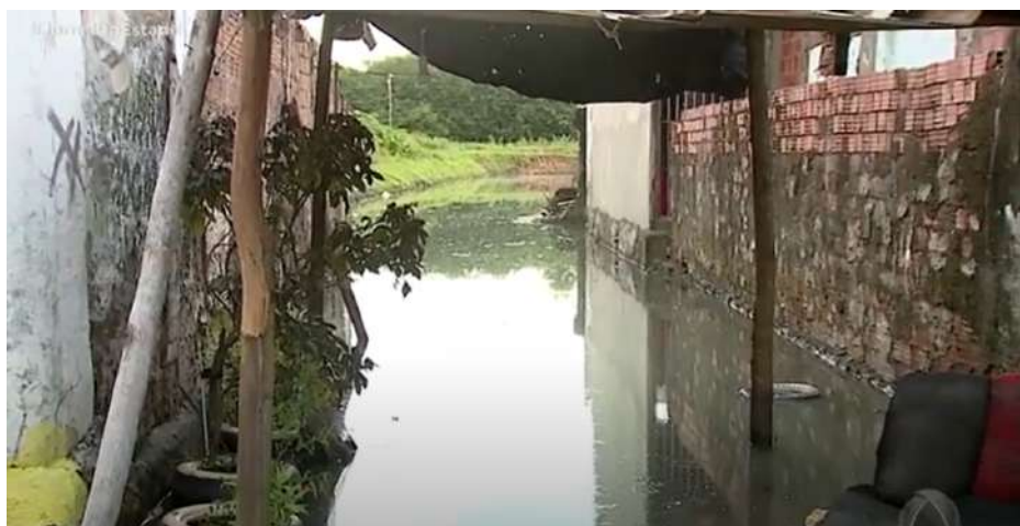
Figura 26: Inundação ocorrida no ano de 2022 no Largo da Aparecida.
