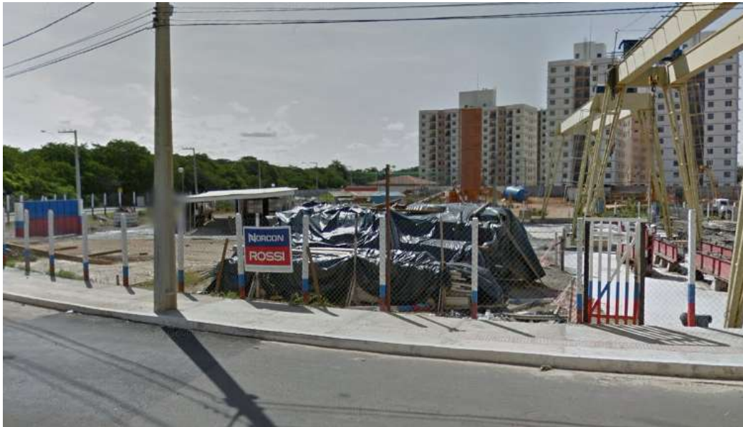
Figura 13: Início da construção do Condomínio Vila Verde.
