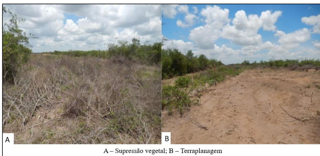
Imagem 31: Supressão vegetal e terraplanagem na área do SABRT-II (Fonte: Adaptado de R.R.M.A.E.P Central eólica brite, 2016).
