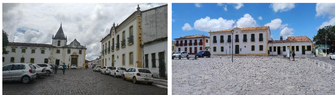
Figura 4.1-4 - Edifícios localizados no entorno da Praça de São Francisco. À esquerda, Igreja e Casa da Misericórdia e Museu Histórico de Sergipe. Foto: Autoria própria, 2026.
