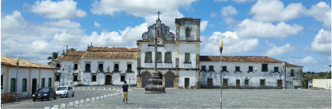
Figura 4.1-5 – Igreja e Convento de São Francisco de Assis. Praça de São Francisco. Foto: Autoria própria, 2023.
