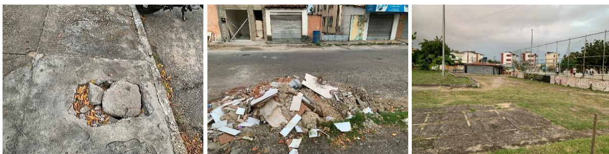
Figura 48: Condições de limpeza e manutenção da Praça Alcebíades Paes, Farolândia
