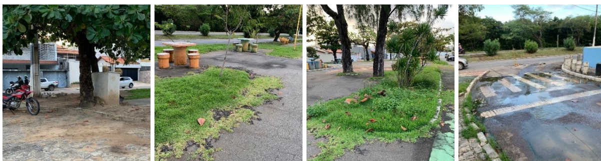
Figura 36: Condições de limpeza e manutenção da Praça Alcebíades Paes, Farolândia
