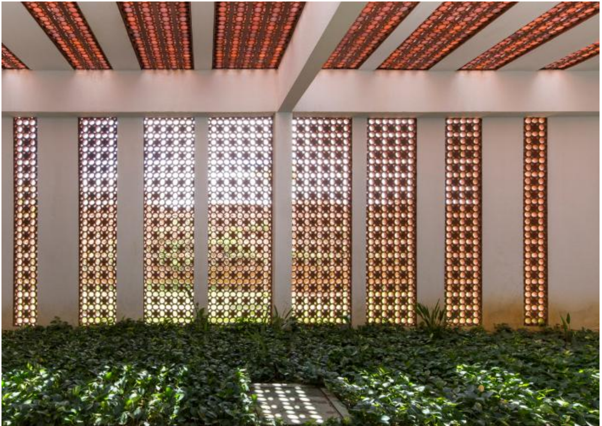
Figura 2 - Fachada de Cobogó
