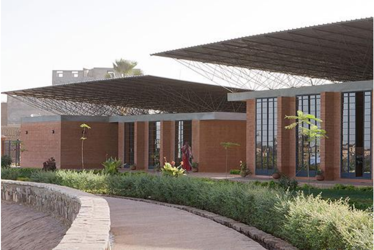
Figura 1- Estrutura Telhado Duplo
