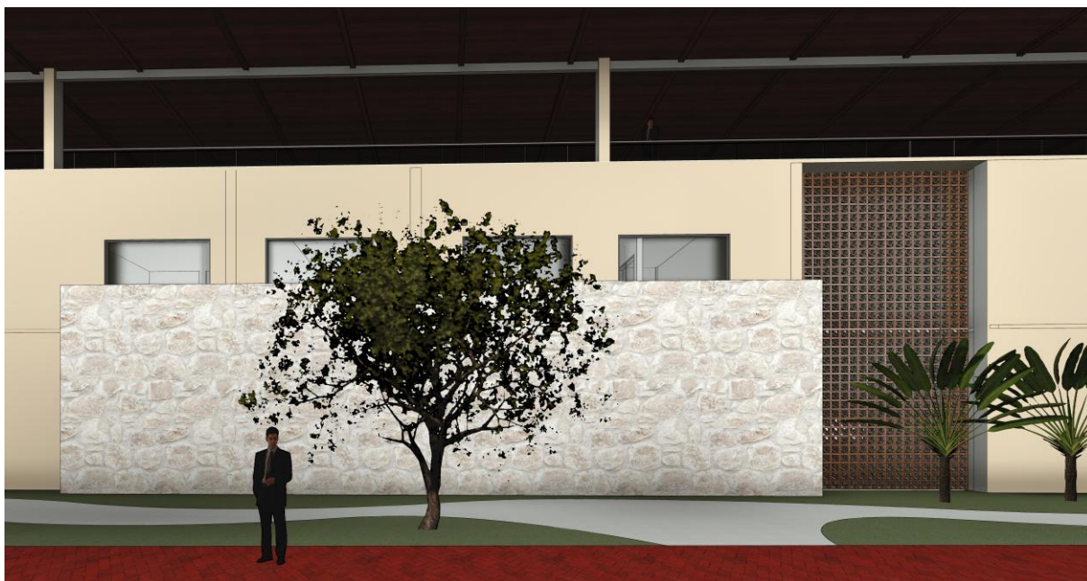
Figura 55 - Parede Dupla e Parede de Cobogó
