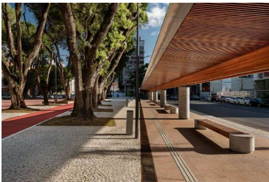
Figura 16 - Terminal de ônibus da praça Marechal Deodoro.
