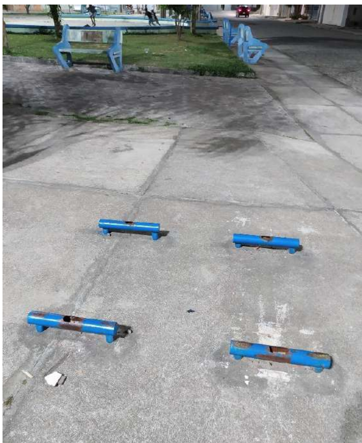
Figura 31 - Equipamento da academia pública em completo desuso.
