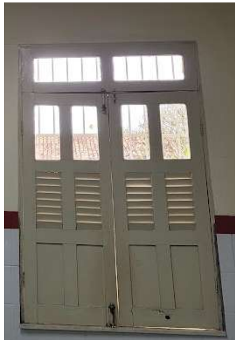
Figura 83 - Janela veneziana com frestas na Sala de ensaio 02
