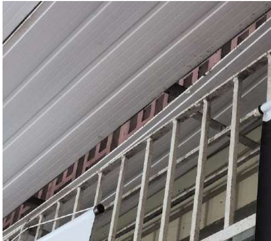
Figura 86 - Vista externa dos cobogós acima do forro da Sala de ensaio 01
