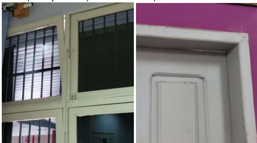
Figura 84 - À esquerda janela emperrada e à direita porta com fresta na Sala de ensaio 01
