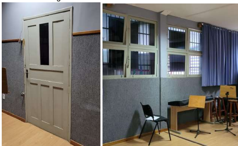
Figura 41 - Porta e Janelas da Sala de ensaio 01
