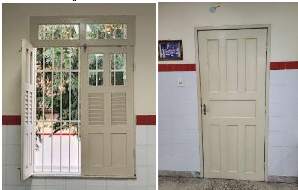
Figura 44 - Janela e Porta da Sala de ensaio 02
