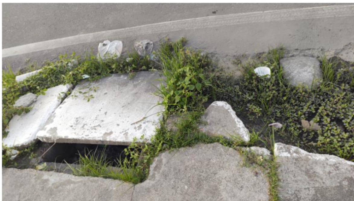
Figura 24: Caixa de esgoto aberta
