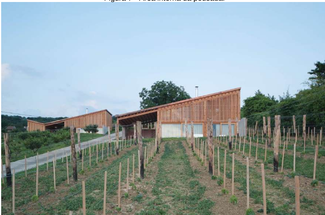
Figura 7 - Área interna da pousada.
