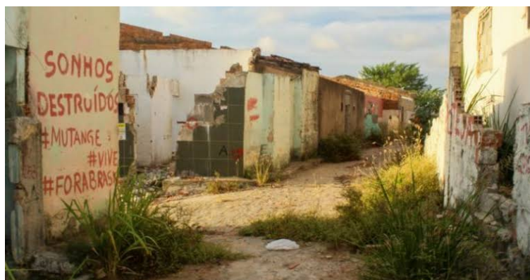
Figura 4 — As marcas do crime e o protesto nas paredes das ruínas do bairro Mutange em Maceió/AL.
