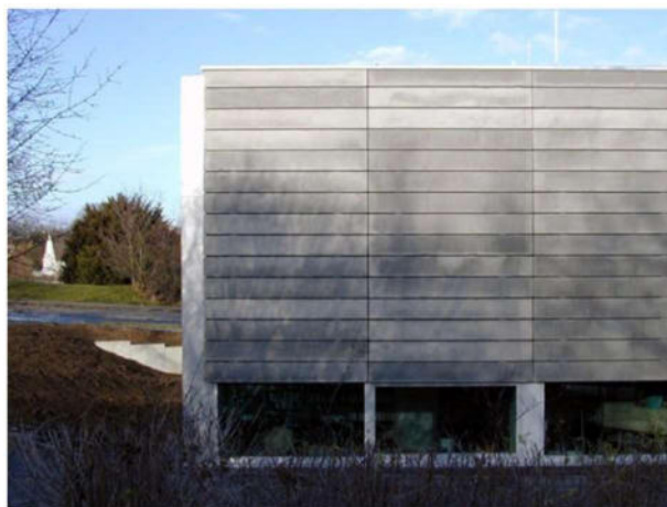
Figura 9 - Fachada da extensão do pavilhão de ensaios do Instituto de Concreto Estrutural; Universidade RWTH Aachen, Alemanha.
