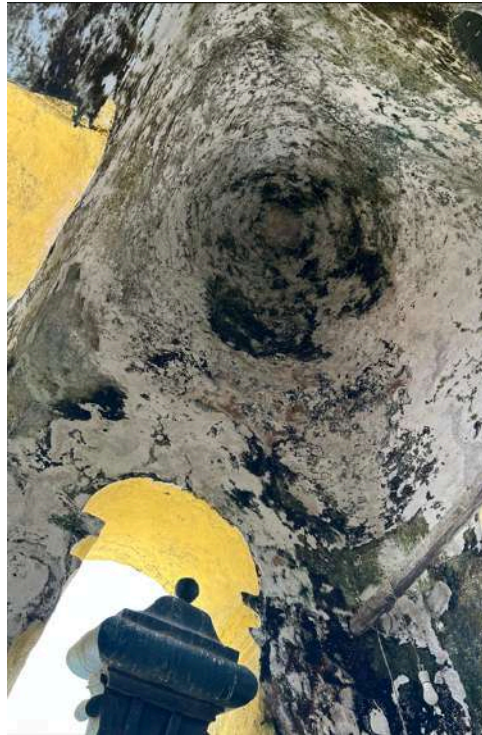
Figura 3: Crosta negra na cúpula da torre.
