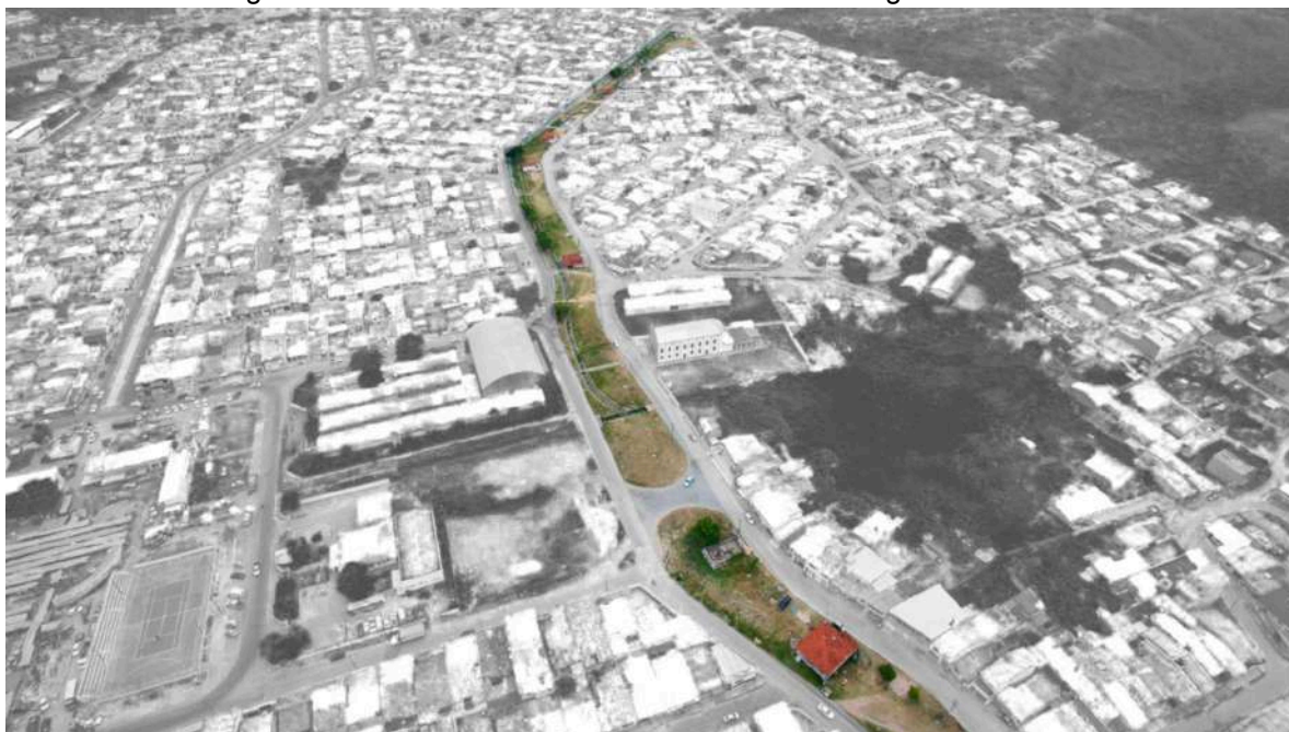
Figura 3: Vista aérea da Avenida Pastor José Rodrigues Sobrinho
