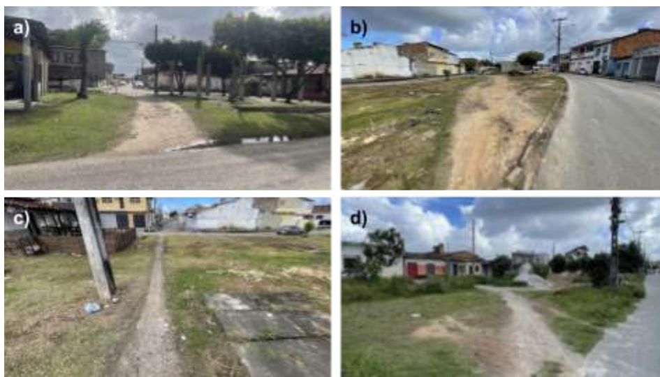
Figura 32: a) e b) Via de transição entre faixas c) e d) Caminhos de desejo traçados pelos usuários da via
