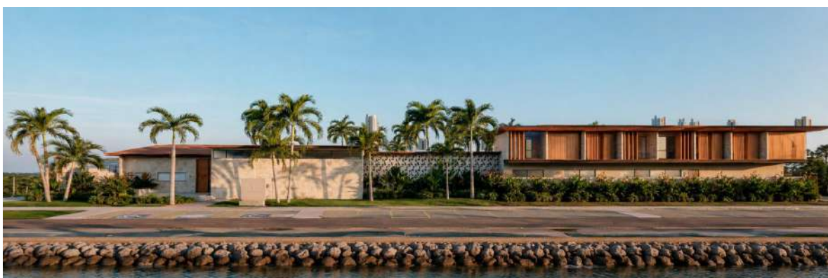
Figura 69 - Vista da fachada principal do equipamento Vienna.
