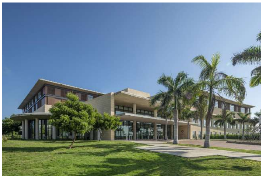
Figura 20 - Fachada principal do Hospital Jardim.
