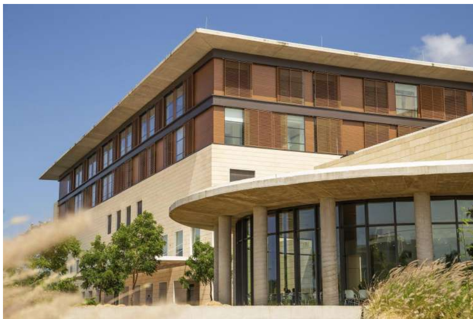
Figura 26 - Beirais prolongados e brises deslizantes nas janelas.
