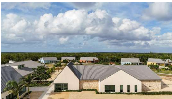
Figura 28 - Edifício principal em primeira instância e residências terapêuticas em segundo plano.
