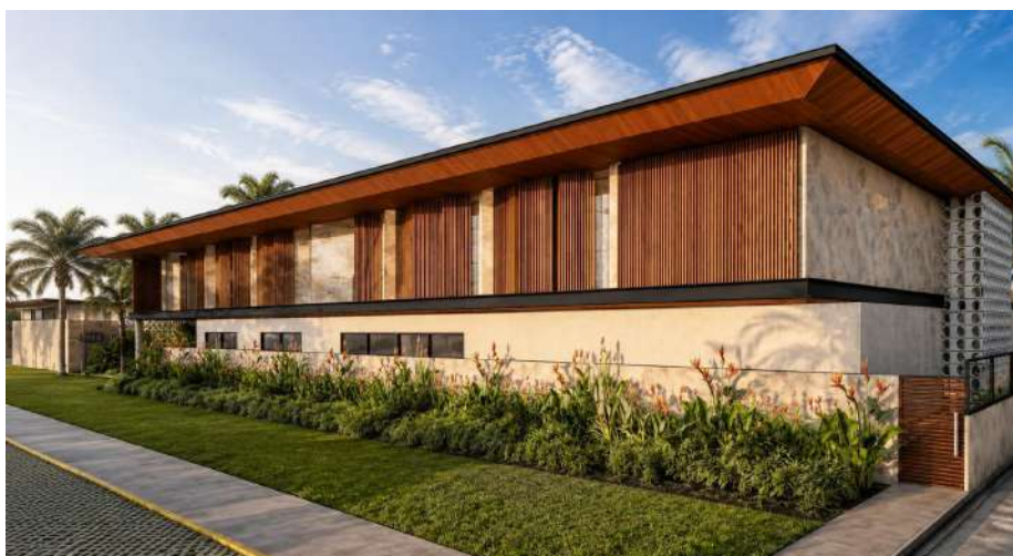
Figura 70 - Vista do bloco de acolhimento temporário.
