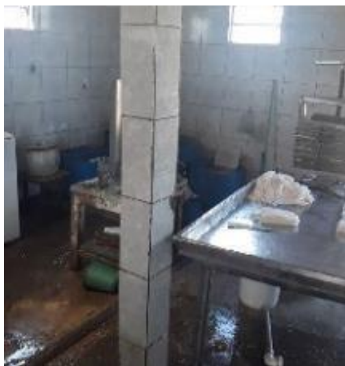
Figura 18: Ambiente sem higiene adequada e acúmulo de água.
