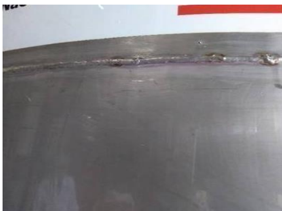
Figura 15: Solda de tanque irregular, propício a acúmulo de produto e formação de biofilme.
