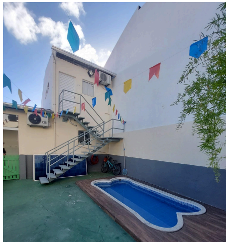
Figura 19: Piscina de hidroterapia e entrada para o laboratório. Fonte: Arquivo pessoal (2026).
