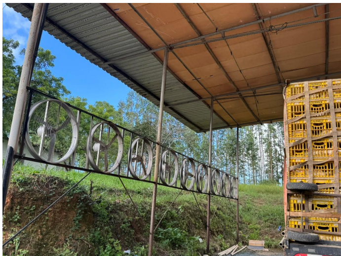
Figura 12: Galpão com ventiladores e nebulizadores em área de espera em abatedouro. Fonte: Arquivo pessoal.
