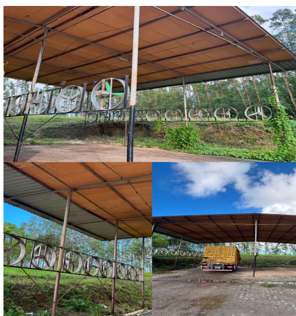
Figura 2: Galpão aberto com telhas metálicas e um forro interno em tons de marrom/laranja, sustentado por pilares de metal escuro e ventiladores com aspersores de água. Fonte: Arquivo pessoal.
