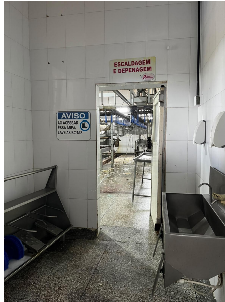
Figura 4: Barreira sanitária da sala de escalda e depenagem em abatedouro. Fonte: Arquivo pessoal.
