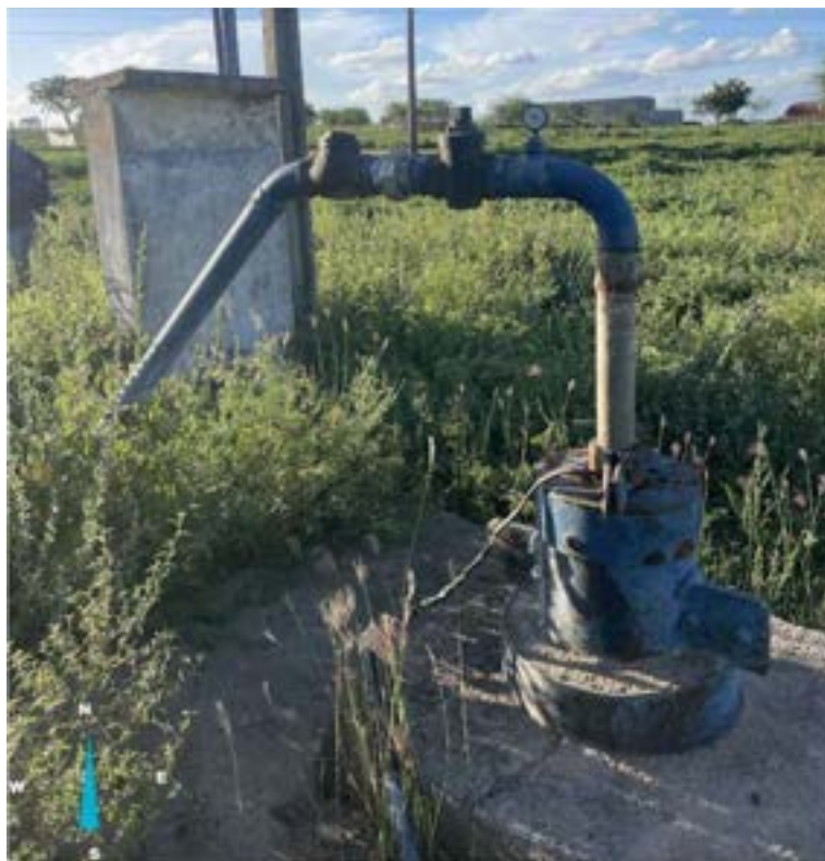
Figura 8 - Poço artesiano que abastece a comunidade de Raspador
