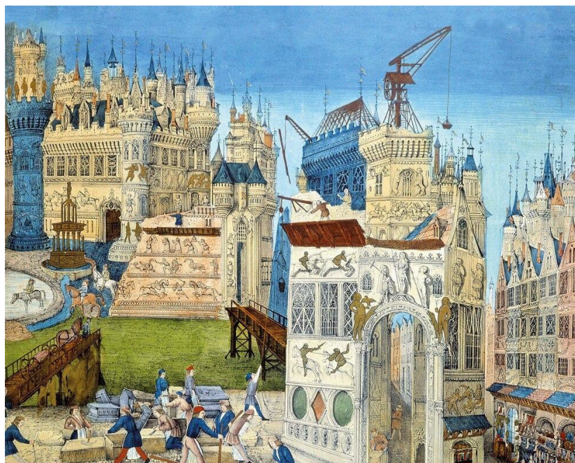
Figura 1- Na ilustração veem-se as gruas, uma inovação utilizada na construção de catedrais góticas
