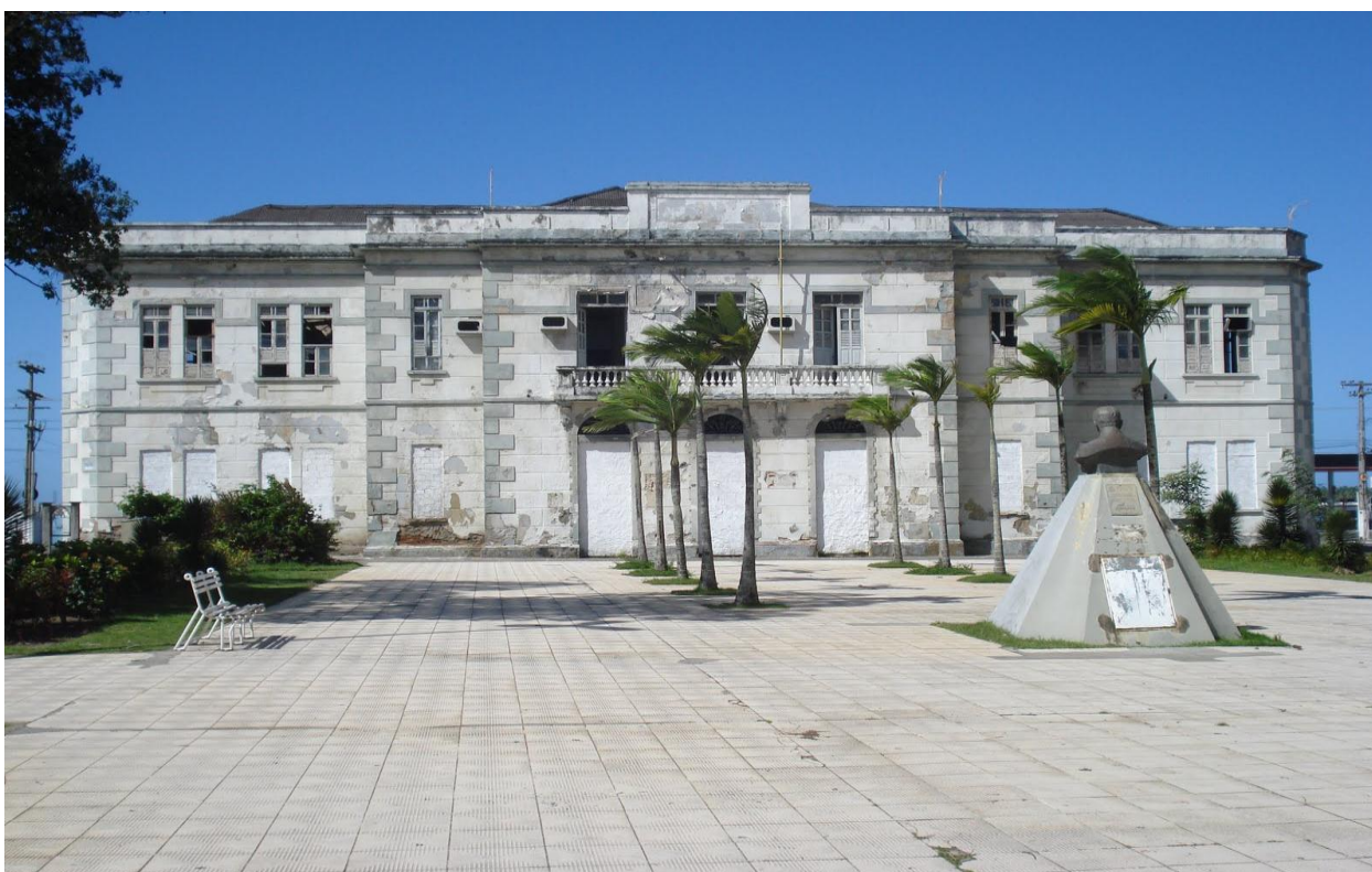
Imagem 08 - Prédio da Alfândega na atualidade. A visão que se tem é a partir da - Praça General Valadão, estando o seu fundo voltado para a Av. Ivo do Prado que margeia todo o curso do Rio Sergipe, no trecho em que ele percorre a região central da cidade.
