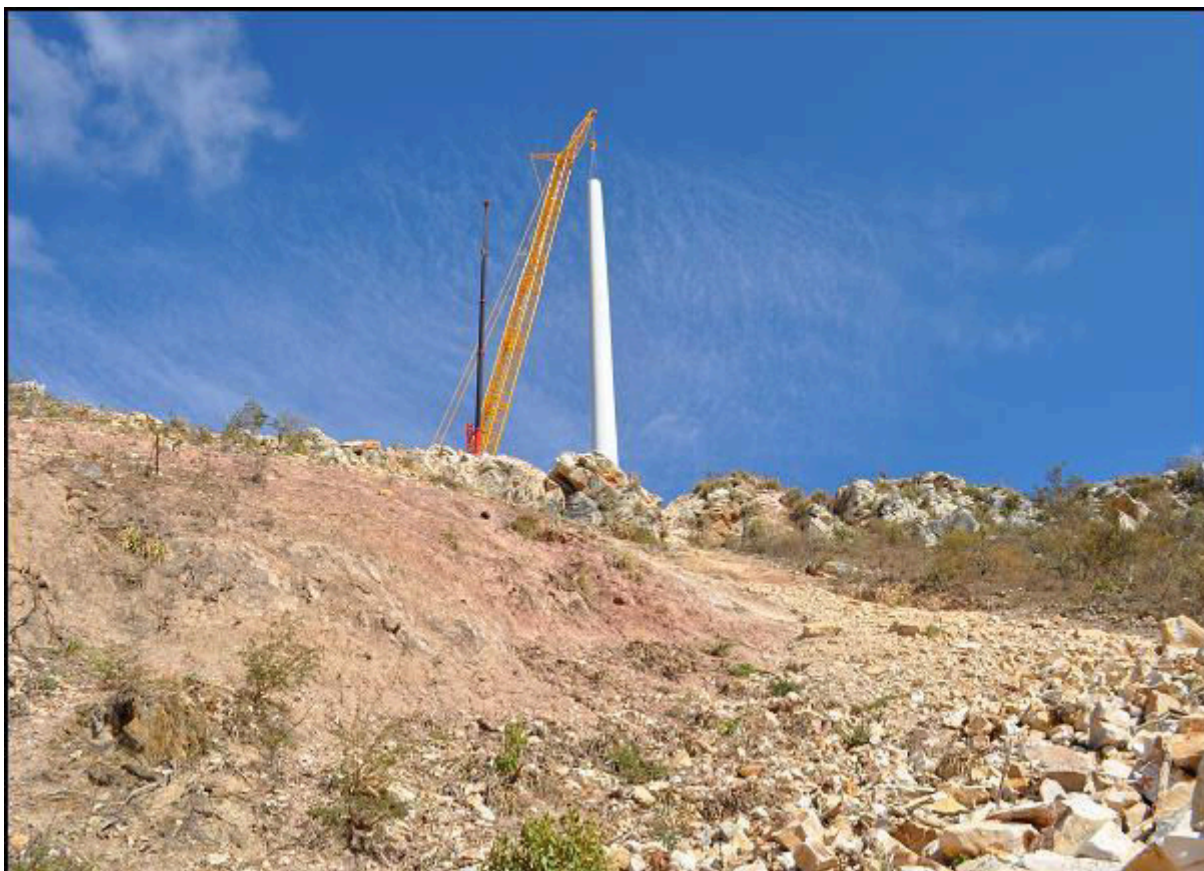
Figura 39 – Rejeitos despejados na encosta da Serra do Olho D'Água
