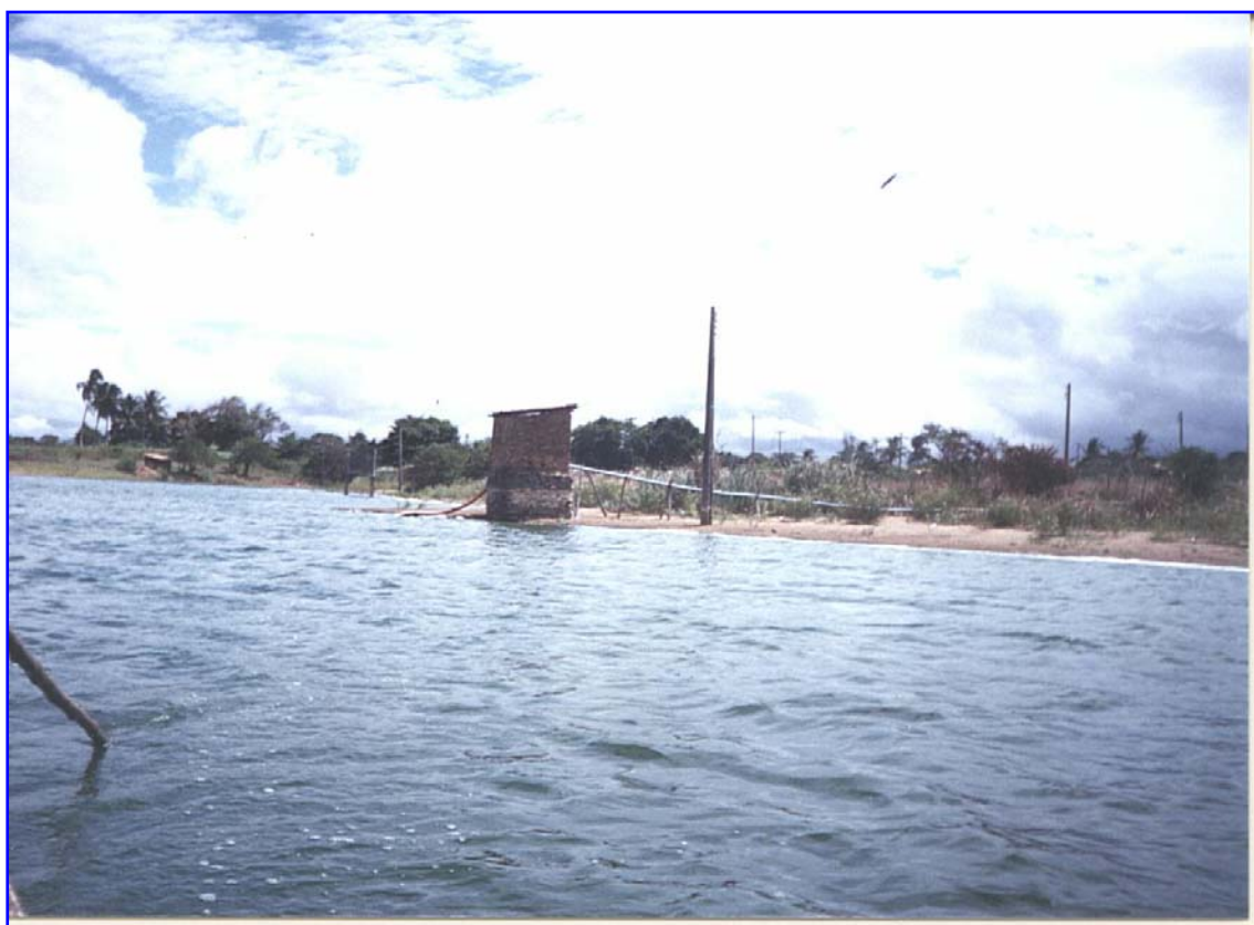
Figura 3.3. Captação de água para irrigação -Casa de Bombas(Gomes, 2003).
