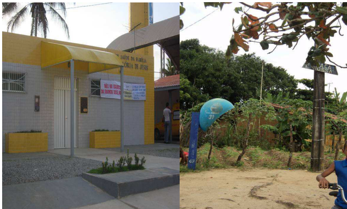
Figura 26: Funcionamento precário do Posto de Saúde e do telefone público no povoado Miranda
