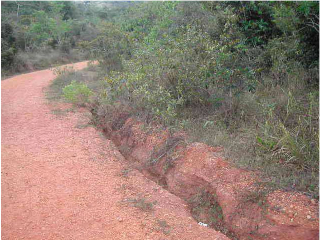
Figura 09 – Registro de processos erosivos sob o solo da Mata do Junco.
