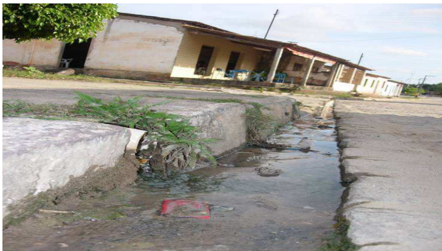
Figura 21: Falta de Saneamento Básico no Povoado Boa Vista
