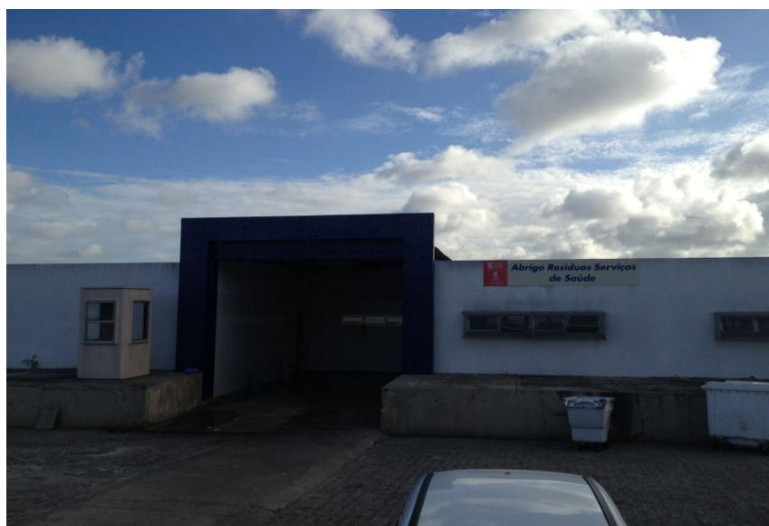
Figura 3.4: Abrigo de resíduos de serviços de saúde (Registro fotográfico elaborado pela autora).
