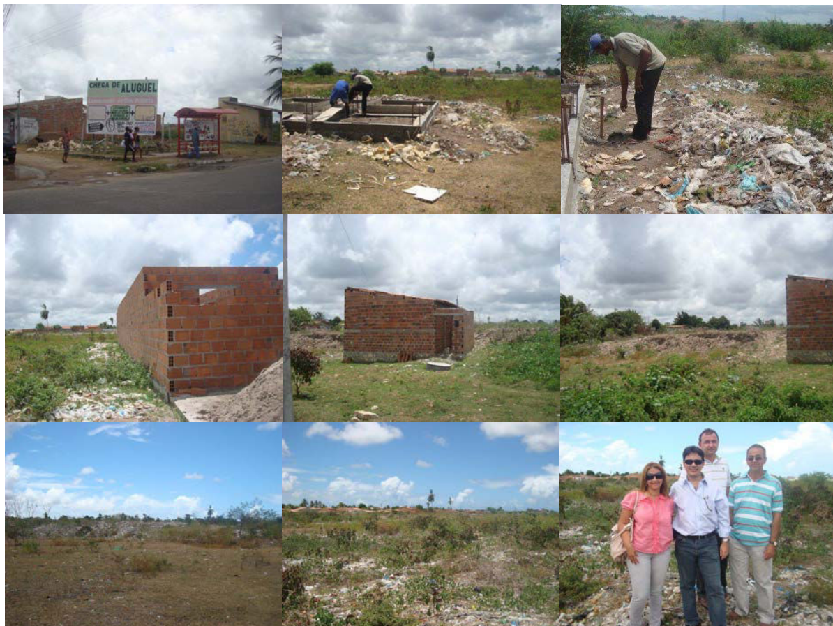
Fotografia 41: Nossa Senhora do Socorro: Loteamento Jardim Piabeta e vazadouro da Piabeta. Observa-se da esquerda para a direita e de cima para baixo: comercialização de unidades do loteamento; construção de casas na área do antigo vazadouro da Piabeta com retirada de material inorgânico que estava enterrado e a presença de resíduos inorgânicos recobertos parcialmente por vegetação. Visita realizada em 17/03/2010.
