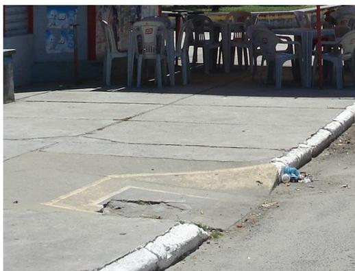
Figura 90: Rampas para P.D com rachaduras
