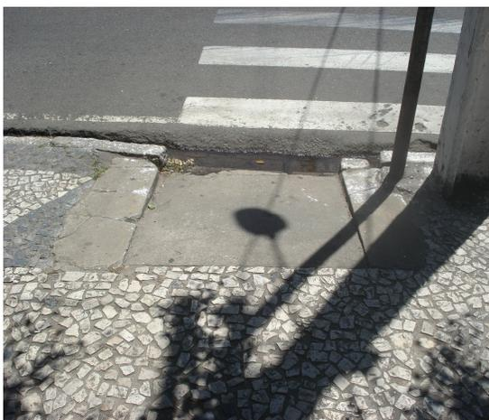
Figura 09: Detalhe Rampa de Acesso P.D
