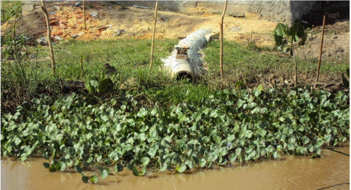
Figura 7 - Tubulação direcionando o lançamento de esgoto doméstico no duto da água de drenagem.
