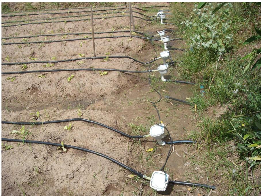
Fotografia 6. Instalação das eletroválvulas.
