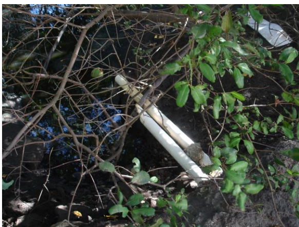
Figura 3.16: Lançamento de efluentes domésticos no bairro 13 de Julho, em Aracaju.
