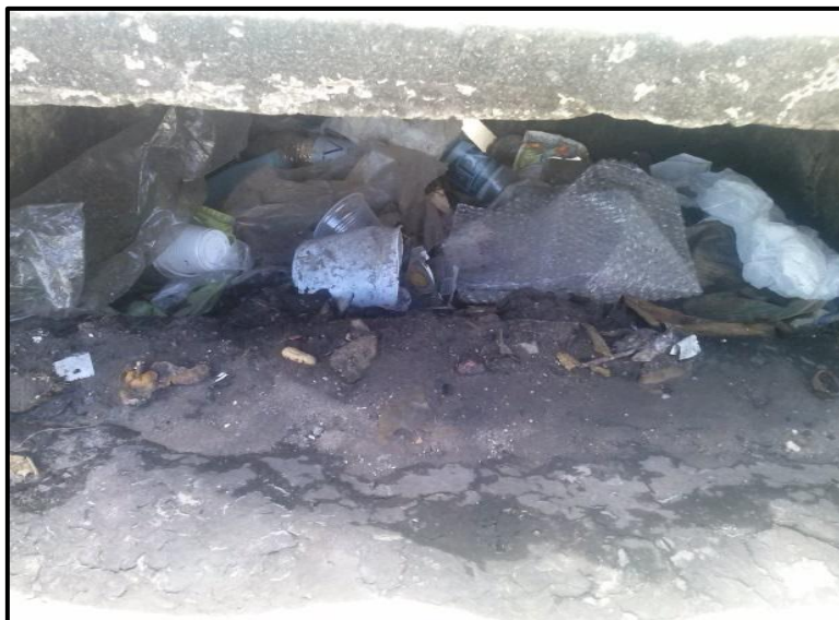
Figura 2.2: Boca de lobo obstruída por resíduos na Av. Airton Teles, Aracaju/SE (10/07/2014) Fonte: O Autor
