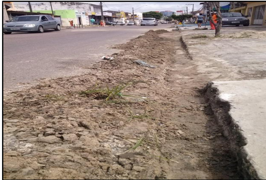
Figura 4.4: Limpeza de sarjeta na Av. Rio Grande do Sul, Conj. Lourival Batista, Aracaju/SE (16/08/2014). Fonte: O Autor
