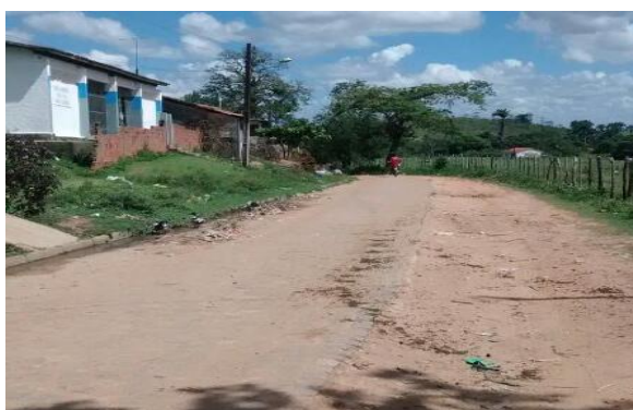
Figura 3.9 – Rua Marechal Deodoro da Fonseca com pavimentação incompleta Fonte: Itamar Prado Barros
