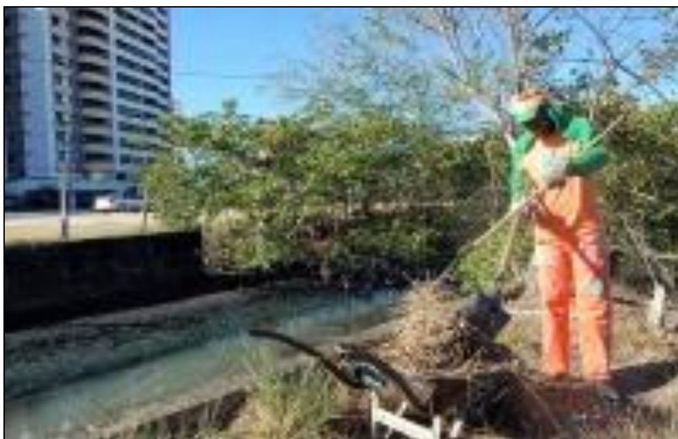
Figura 5.4: Limpeza do canal Tramandaí Fonte: PMA, 2010.
