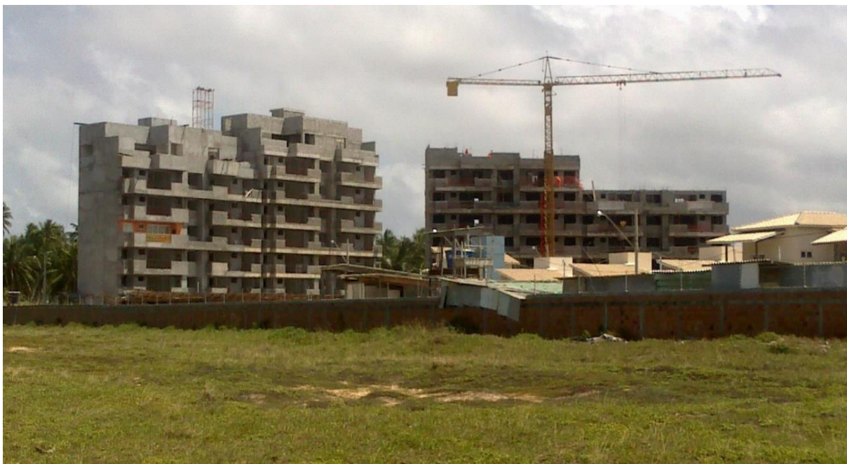
Figura 4.18 – Construção do Condomínio Residencial Portal dos Trópicos, na planície costeira.
