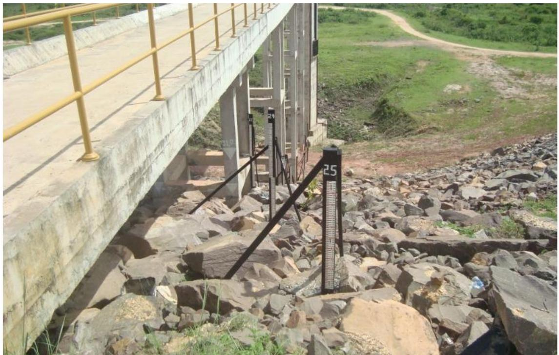
Figura 2.9– Vista a montante do talude da Represa do rio Poxim-açu. Detalhe das réguas instaladas para acompanhamento do enchimento da represa. Fonte: autor.
