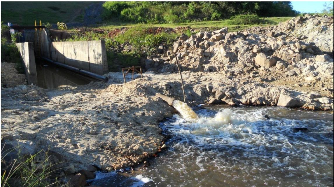
Figura 2.8– Aspecto lançamento da água de fundo da barragem, vazão regular de  $0,2\text{m}^3.\text{s}^{-1}$ .
