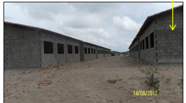
Fig. 4.12: Casas em construção pelo Município.
