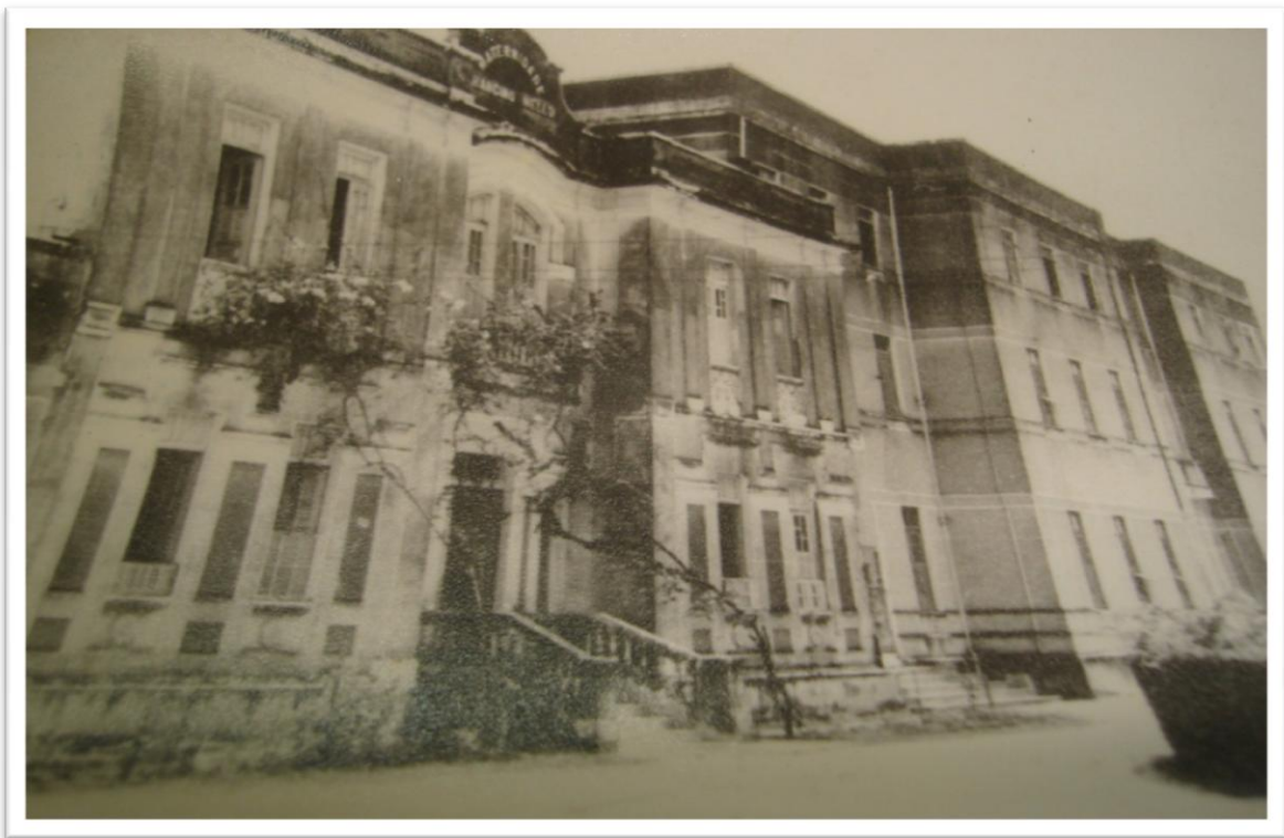
Figura 03: Fachada da Maternidade Francino Melo. Fonte: Arquivo do Hospital de Cirurgia. Sem data.
