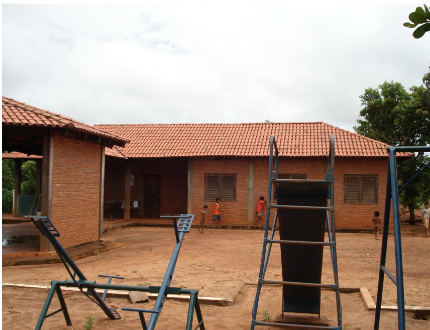
Foto 11 – Área de recreação do prédio escolar. Fonte: Imagem fotografada pela autora.
