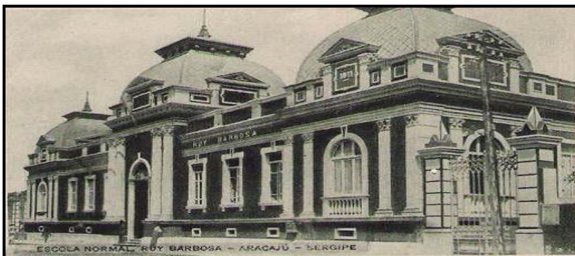
Figura 04. Prédio da Escola Normal Rui Barbosa
