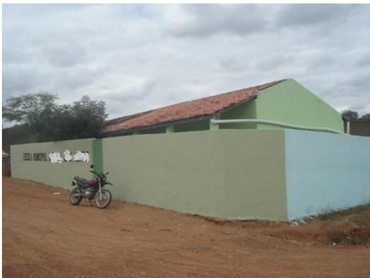
Foto 32 – Fachada da Escola
