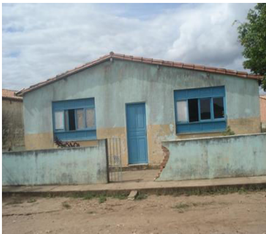
Foto 14 – Fachada da escola
