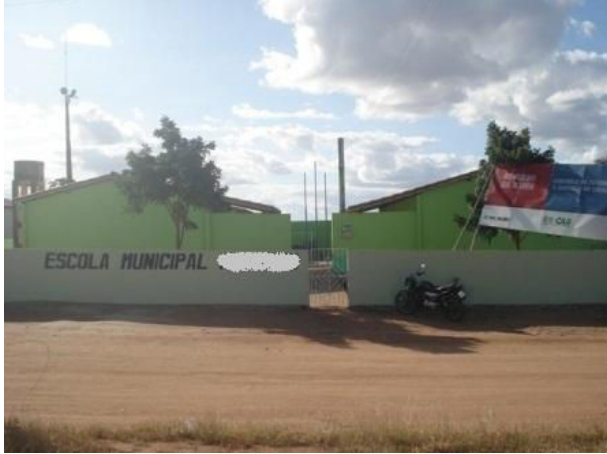
Foto 5 – Fachada da escola
