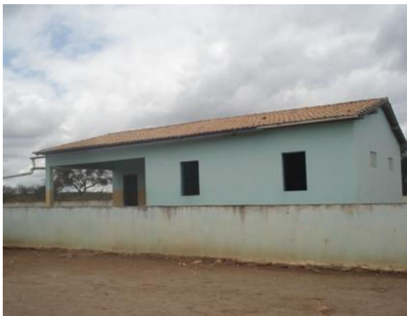
Foto 38 – Fachada da Escola
