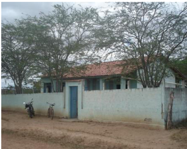
Foto 20 – Fachada da escola
