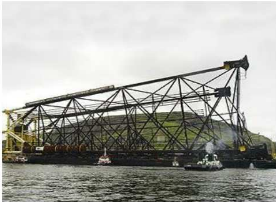
Figura 2.2 – Jaqueta da plataforma de Mexilhão sendo transportada até a Bacia de Campos (pedesenvolvimento.com, 2009)
