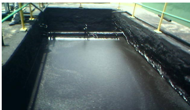
Figura 8 - Separador Gravitacional.
