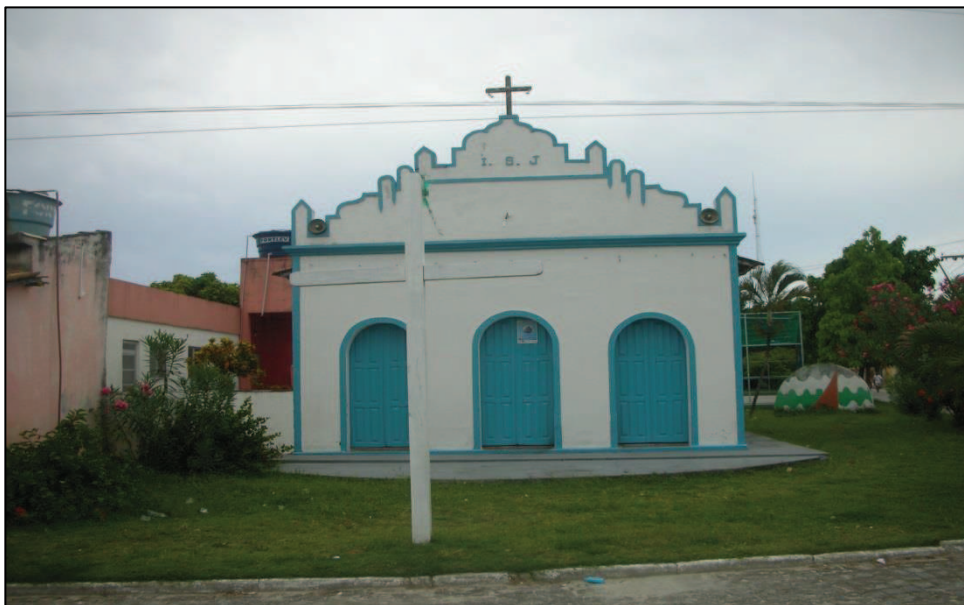
Figura 42 – Povoado Terra Caída/ capela São José
