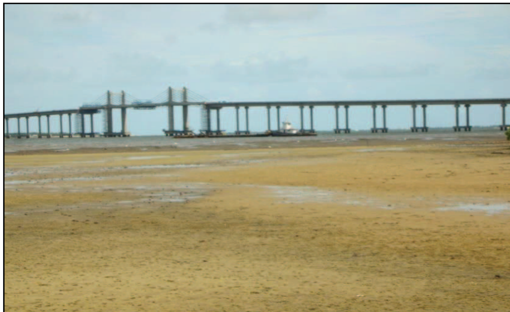
Figura 30 - Ponte Gilberto Amado construída sobre o estuário do Rio Piauí-Fundo-Real, Terra Caída
