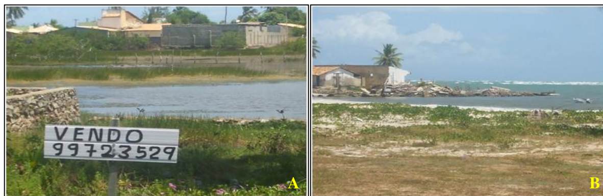
Figura 78 A e B. Ocupações irregulares (A e B) e erosão costeira (B) na Praia do Saco/Estância.
