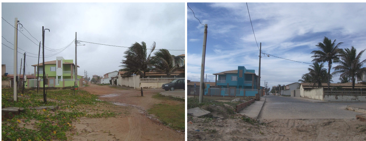
Figura 56 - Rua Caravelas em 2005 e após a instalação da rede de drenagem e do calçamento em 2011. Créditos: Emerson Alves Ribeiro, 2011/Plano Diretor do município de Itaporanga D'Ajuda, 2005.
