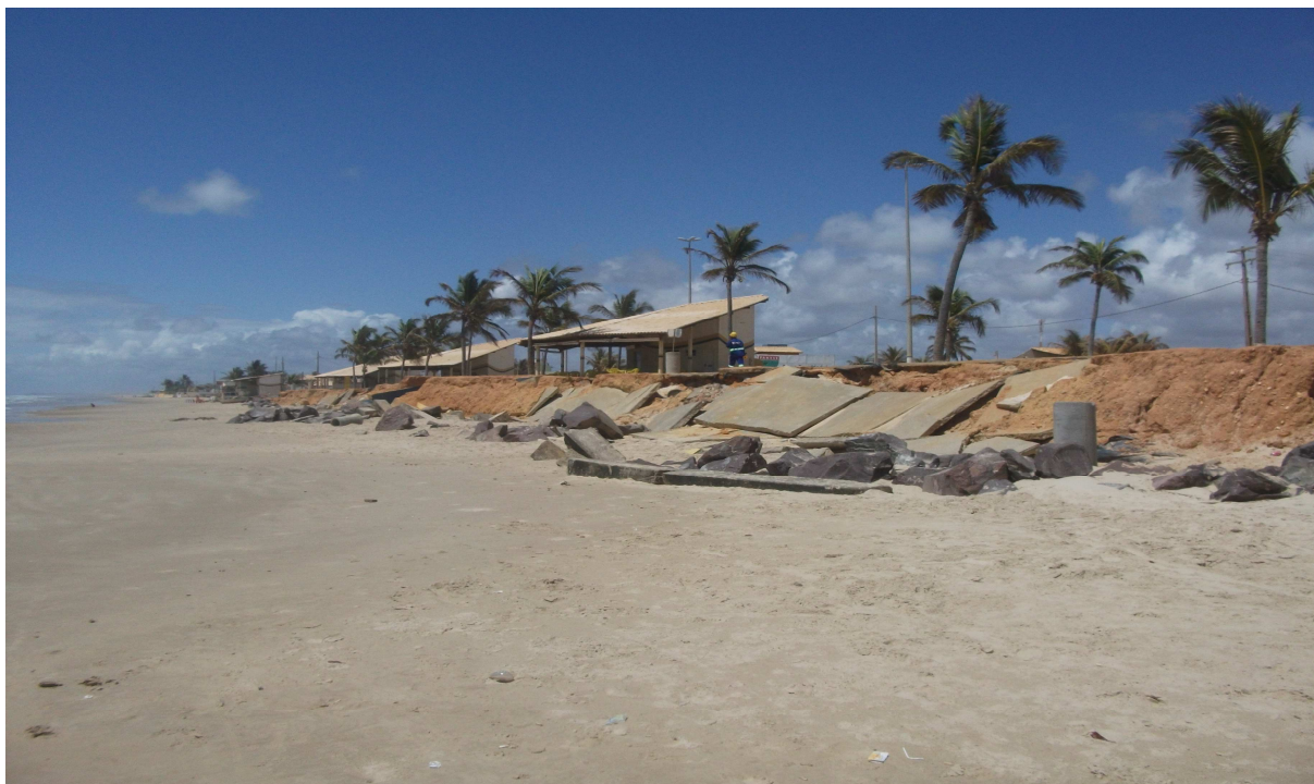
Figura 51 - Orla turística com blocos de rochas e entulhos parcialmente cobertos por piçarra. Crédito: Emerson Alves Ribeiro, 2011.
