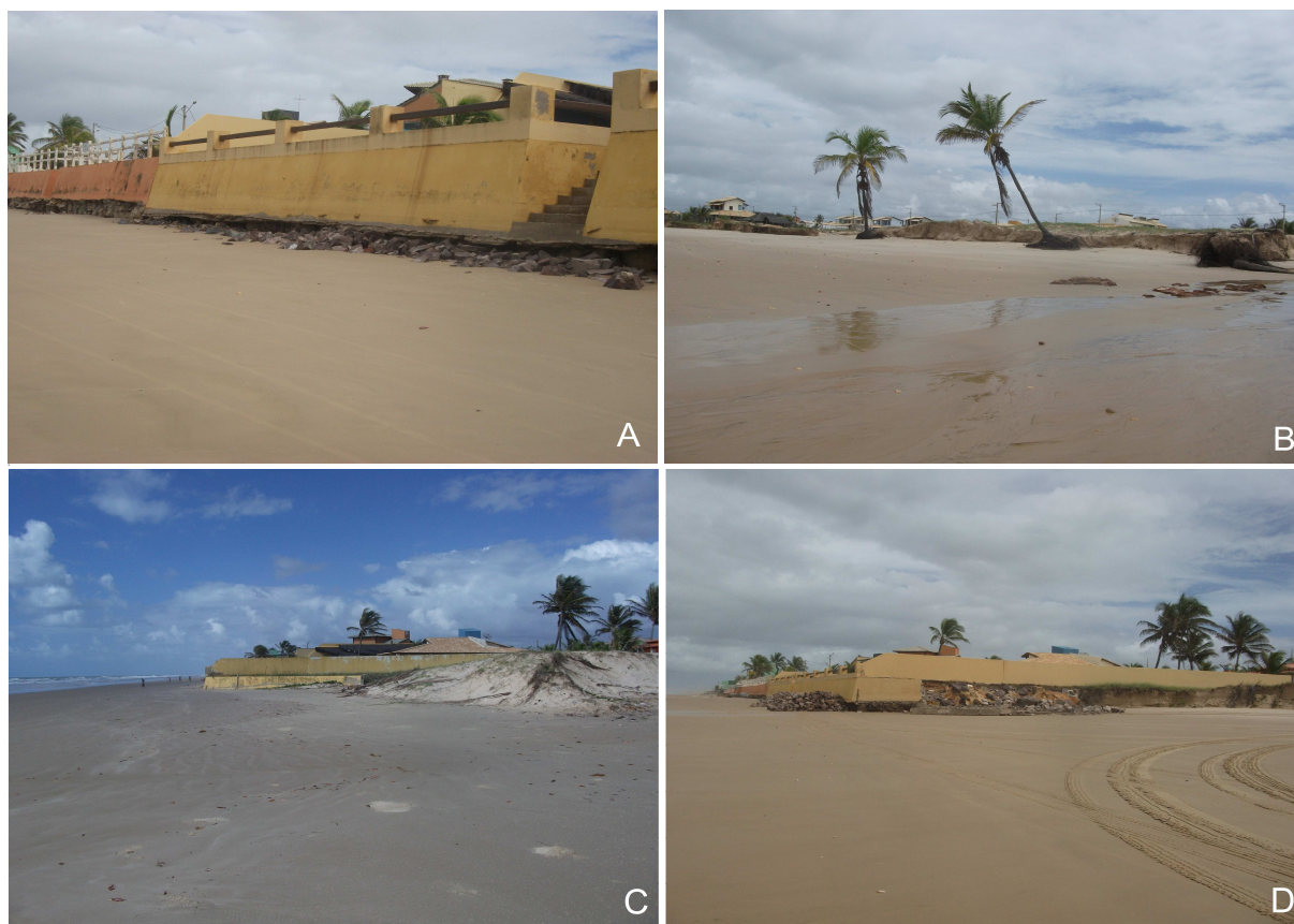
Figura 40 - Imóveis construídos irregularmente sobre área de proteção. Crédito: Emerson Alves Ribeiro, 2010.
