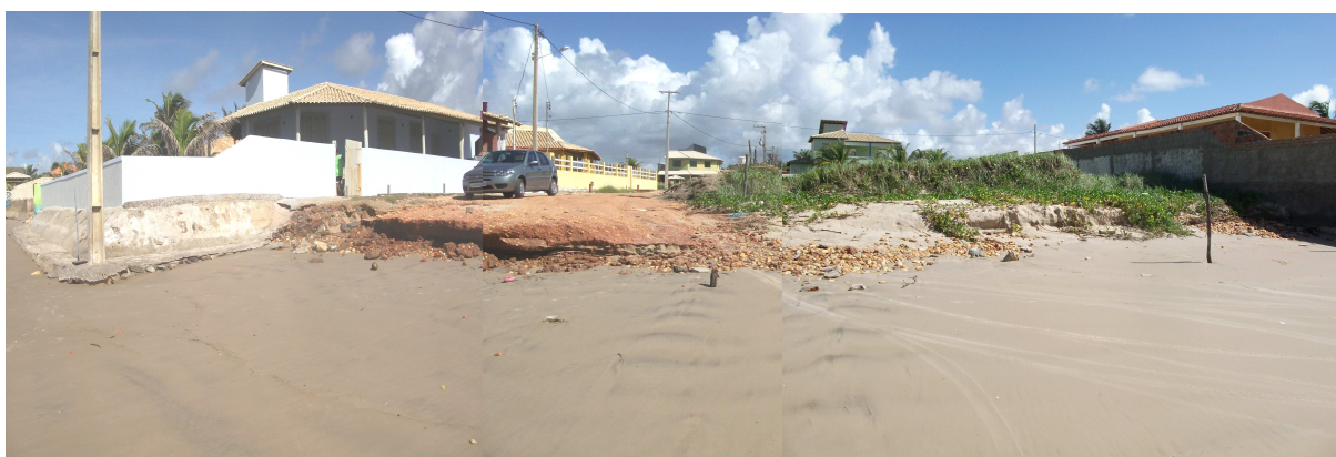
Figura 38 - Perfil 5: aspectos erosivos, abril de 2010.
