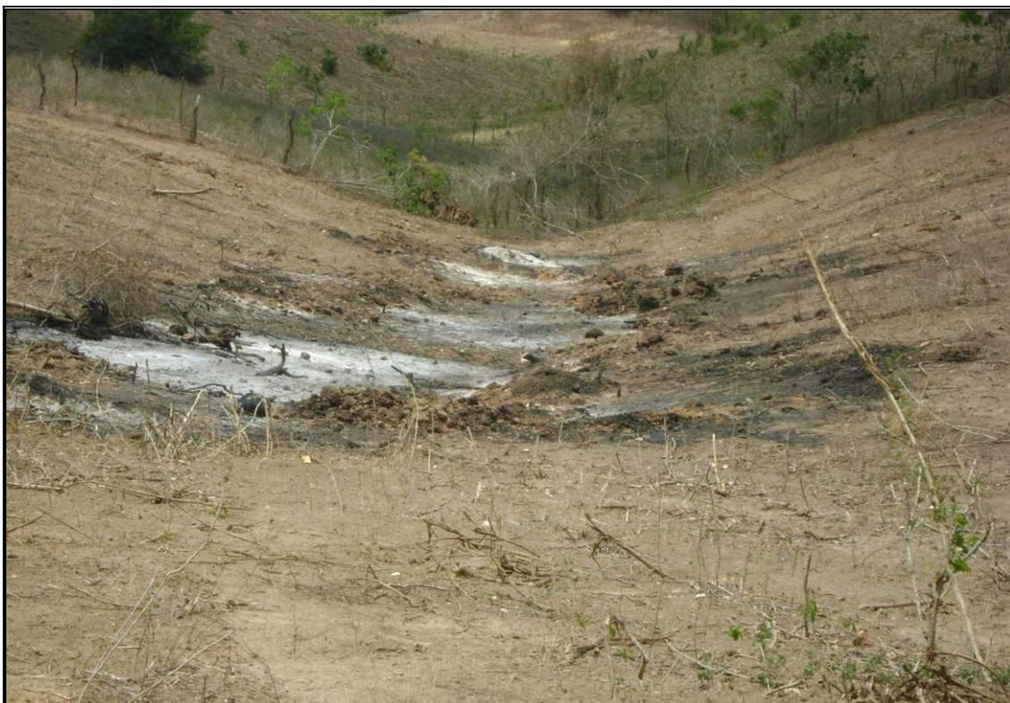
**Figura 09: Limpeza do terreno ondulado de montante para jusante e formação de coivaras.**
