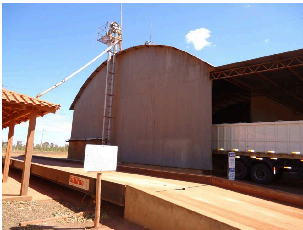
Figura 47: Classificação, pesagem e descarregamento na Moega
