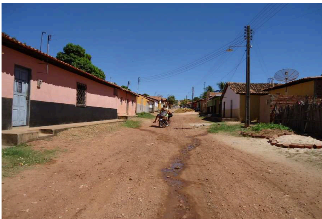
Figura 100: Ruas sem pavimentação e sem esgotamento sanitário
