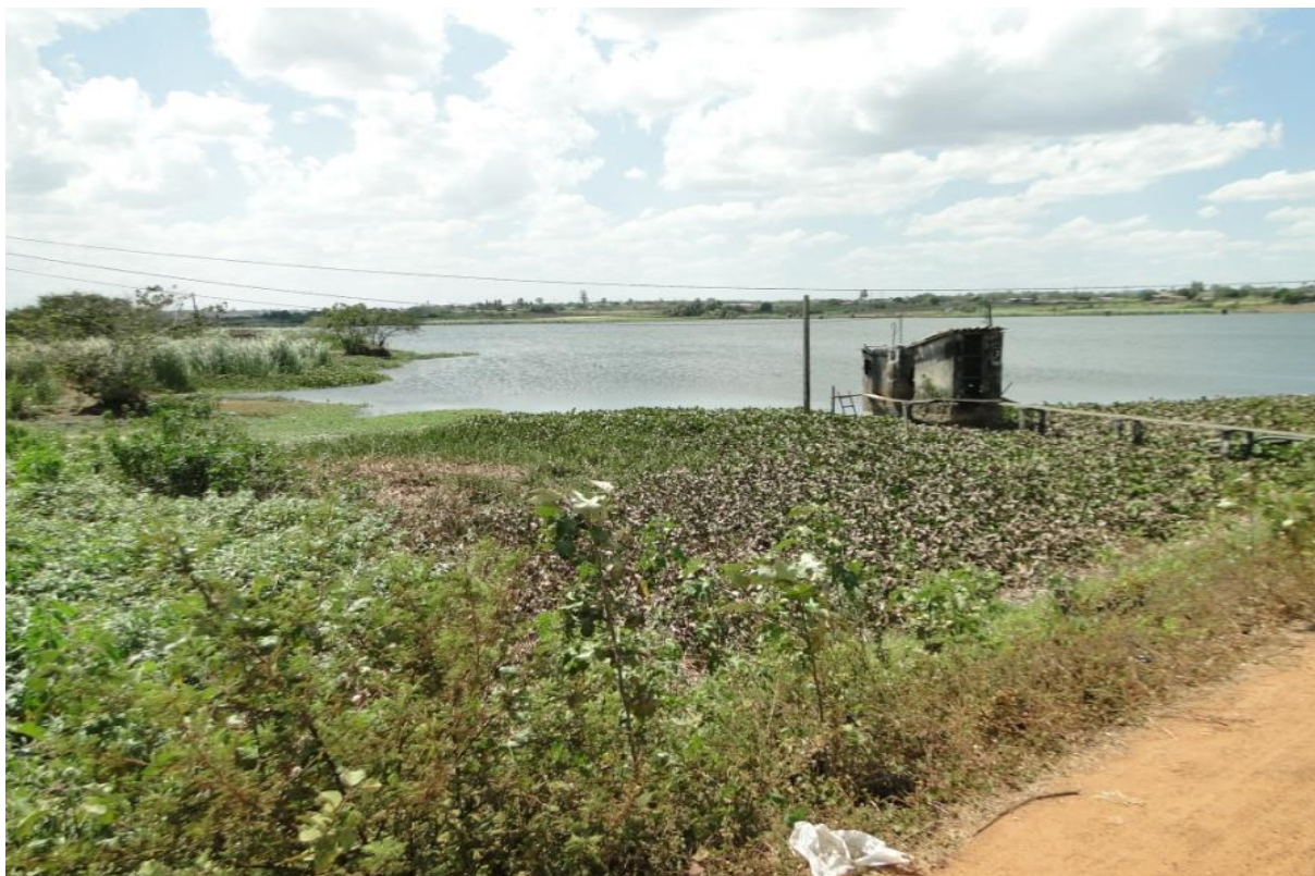
Figura 30: Tomada d'água para irrigação no Açude da Macela em Itabaiana. Fonte: SOUSA SILVA, Luiz Carlos, 2013.
