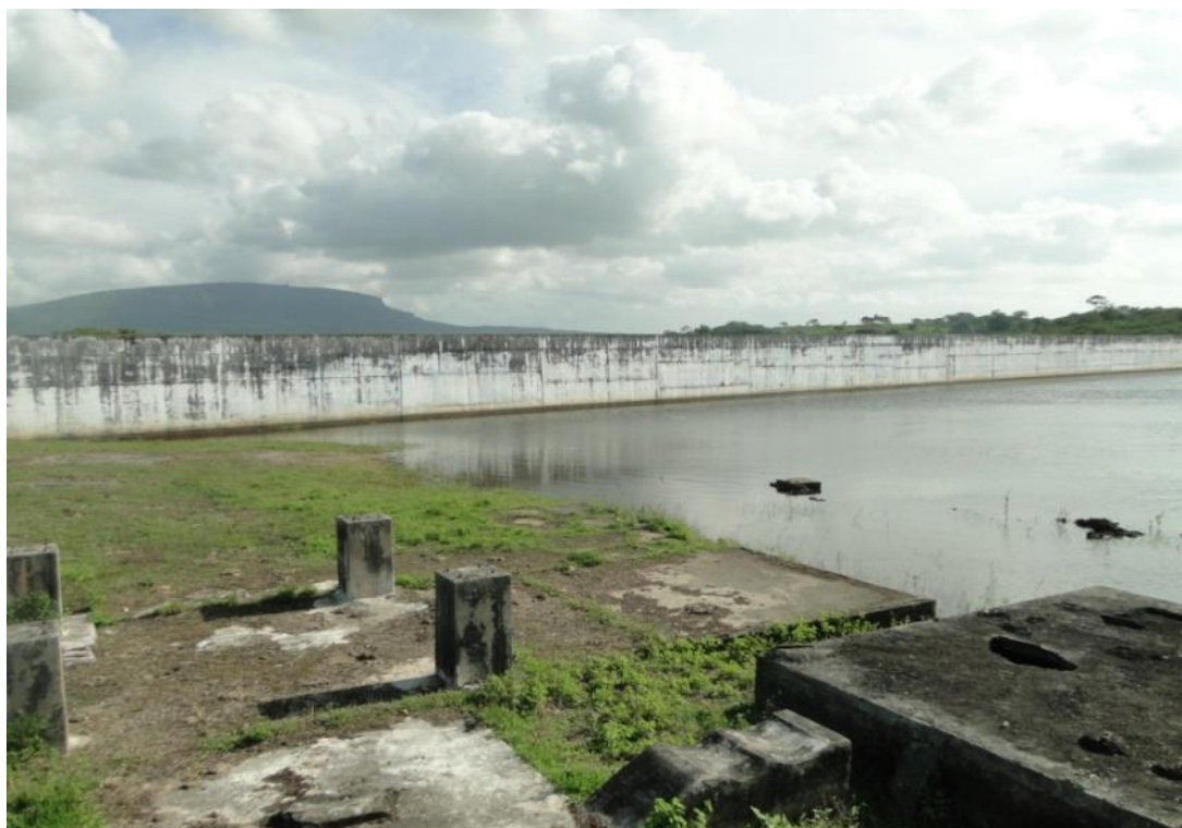
Figura 31: Vista interna do reservatório e vertedouro da Barragem Jacarecica I. Fonte: SOUSA SILVA, Luiz Carlos, 2013.
