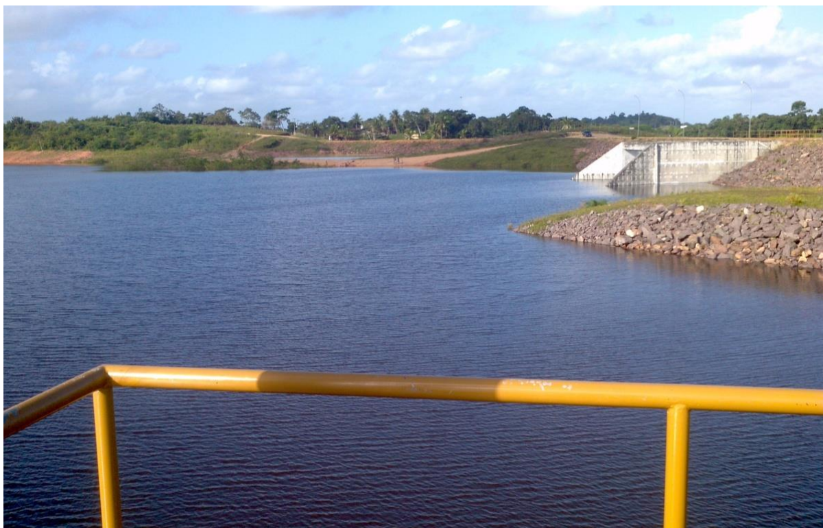
Figura 33: Vista do reservatório hídrico da barragem Poxim-Açú em São Cristóvão/SE. Fonte: SOUSA SILVA, Luiz Carlos. 2013.
