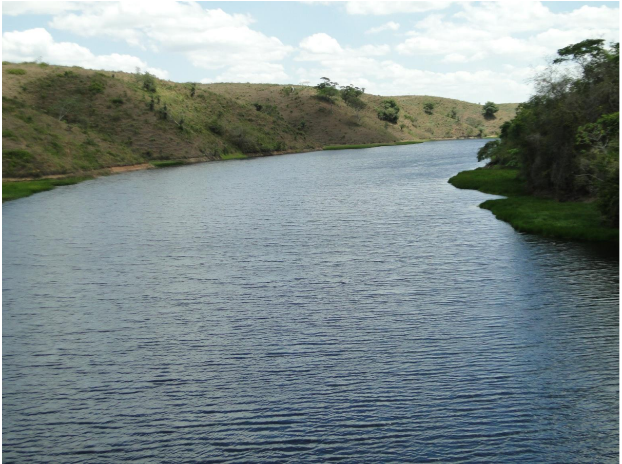
Reservatório hídrico da Barragem Jacarecica II, entre os municípios de Areia Branca e Malhador.
