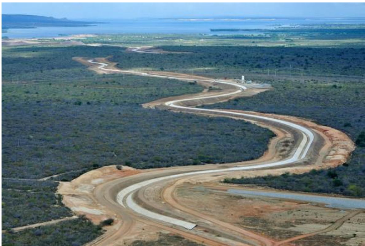
Figura 36: Canal de derivação de água de um dos eixos do projeto de transposição do rio São Francisco em Pernambuco. 2012.
